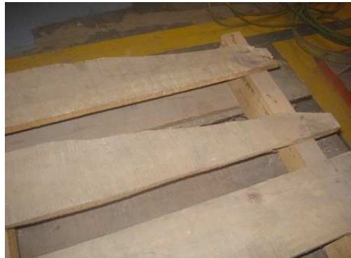
Imagen 11. Tablas deterioradas
