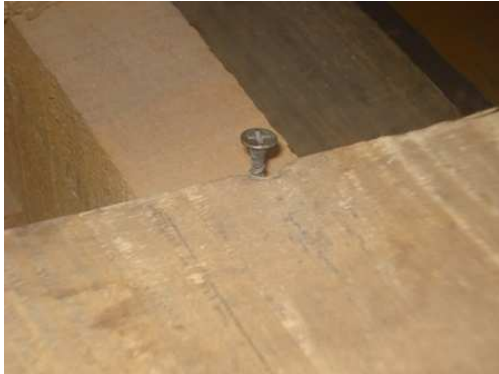
Imagen 10. Clavo suelto
